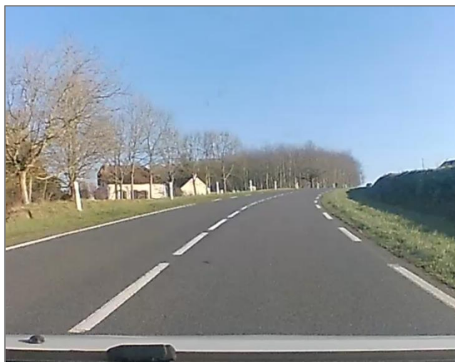
Vue de la D32 en amont de la plateforme. On constate l'absence d'aménagement pour les modes doux
